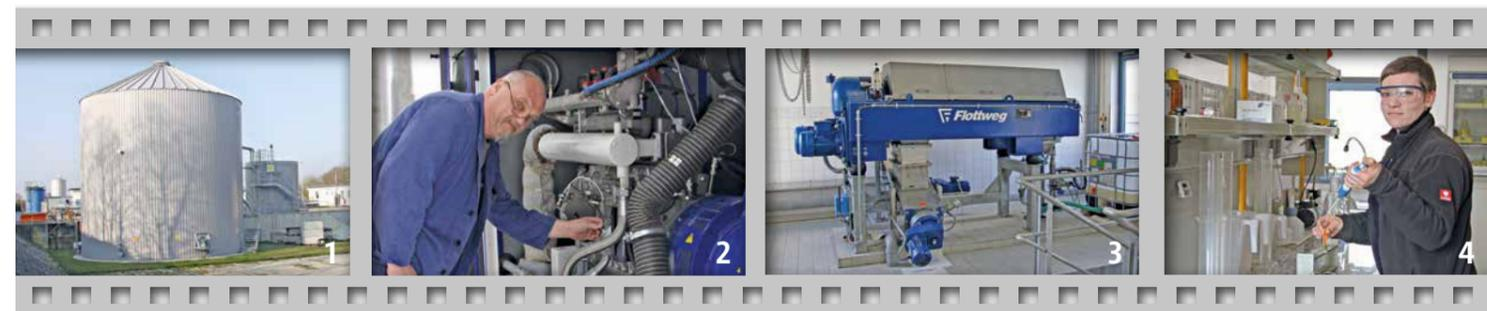
1 - Der Faulbehälter mit 1.175 m<sup>3</sup> Volumen dient zur Erzeugung von Methangas; 2 - Betriebsleiter Reinhard Franke prüft das Blockheizkraftwerk zur Verbrennung des Methangases. 3 - Eine Zentrifuge des Vilsbiburger Maschinenbauers Flottweg dickt den Restschlamm zur weiteren Verwendung ein; 4 - Nicole Böhme, Fachkraft für Abwassertechnik, prüft die Qualität des aufbereiteten Wassers, vor der Einleitung in die Vils
