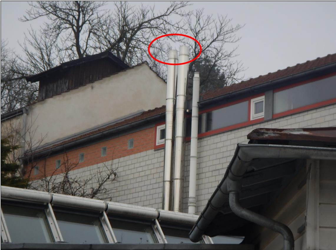
Abbildung 4: Abluftkamine der beiden Backöfen
