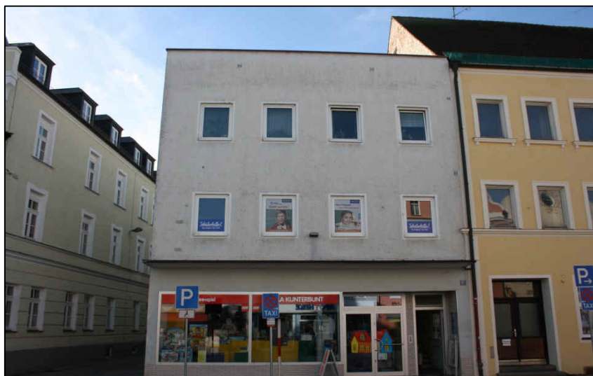
Blick auf die Fassade des Gebäudes am Stadtplatz 27
