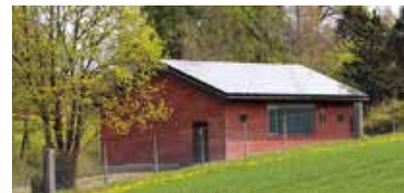
Mit den vier 55 bis 160 Meter tiefen Trinkwasserbrunnen am Saliterweg und am Zeilinger Berg werden jährlich ca. 1,4 Mio m<sup>3</sup> Grundwasser mit PV-Strom-betriebenen Pumpen gefördert. Das einen Quadratkilometer große Wasserschutzgebiet um die Brunnen trägt zur hohen Qualität des Wassers bei.
