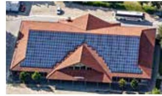
Bereits 2010 installierte die Stadt Vilsbiburg auf der Stadthalle eine 100 kW PV-Anlage und wurde dem Titel „Klimakommune“ als Vorreiter für Kommunen gerecht. 444 Solarmodule erzeugen jährlich ca. 110.000 kWh Strom.
