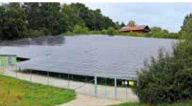
Mit der PV-Freiflächenanlage der Stadtwerke Vilsbiburg am Saliterweg werden jährlich ca. 1,4 Megawatt Strom erzeugt. Etwas mehr als ein Drittel davon wird in der Wasserversorgung zum Betrieb der Brunnen verbraucht. Die Fläche im Wasserschutzgebiet der Brunnen wird dauerhaft als Blühwiese bewirtschaftet und trägt so auch zum Trinkwasserschutz bei.
