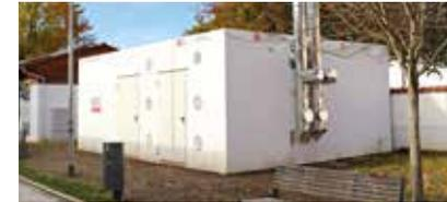
Die Biomasse-Heizzentrale in Fertigungsbauweise am vhs-Durchgang versorgt die vhs, die Sparkasse und ein weiteres Gebäude mit warmem Wasser. 2023 wurde die Anlage anlässlich der Energiekrise mit einem 350-kW-Pelletkessel erweitert und sorgt im Vergleich zum Gaskessel zu einer Einsparung von jährlich ca. 30.000 m<sup>3</sup> importierten Erdgas.
