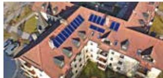
Das Heilig Geist Wohnstift an der Frauensattlinger Straße wird mit Fernwärme für das Brauchwasser und die Heizung versorgt. Die 40 m<sup>2</sup> große solarthermische Anlage auf dem Dach des Hauptgebäudes sorgt für eine Einsparung von ca. 20.000 kWh Wärme, was einer Menge von 2.000 Litern Heizöl entspricht.
