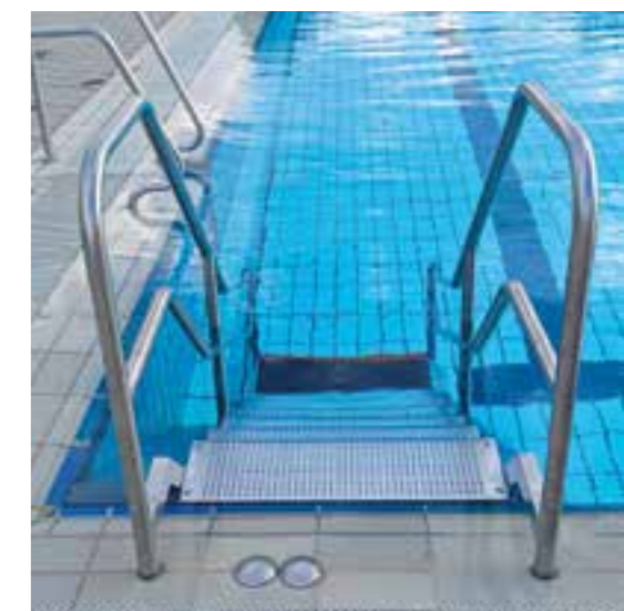
Die häufig gewünschte Einstiegstreppe ins Schwimmerbecken.
