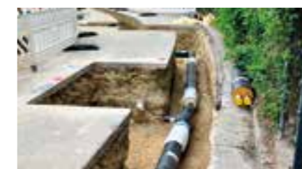
Die Stadtwerke Vilsbiburg sorgen für die Abzweigung der Fernwärmeleitung, den Hausanschluss und den Übergabepunkt beim Kunden.
