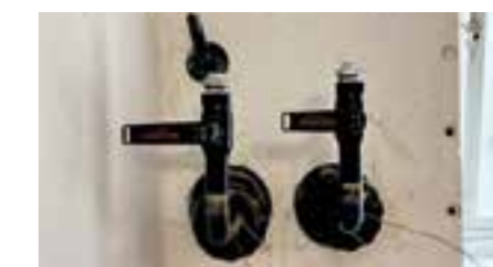
Die Stadtwerke Vilsbiburg sorgen für die Abzweigung der Fernwärmeleitung, den Hausanschluss und den Übergabepunkt beim Kunden.
