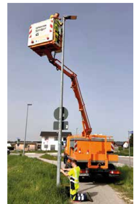
Die Stadtwerke-Elektriker rüsteten 2024 bereits 180 Straßenlampen auf LED-Technik um. Bis zum Jahresende werden im Stadtgebiet noch 100 weitere folgen.
