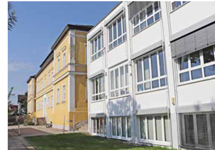
Der Haushalt 2025 beinhaltet u. a. die kostenintensive Erhaltung und Instandhaltung vieler seit langem genutzter Immobilien, wie das Johanneshaus oder die ehemalige Krankenpflegeschule in der Frontenhausener Straße.
