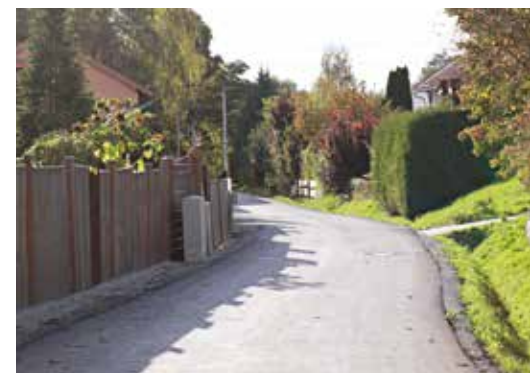
Blick in die neu asphaltierte Gruber Straße
