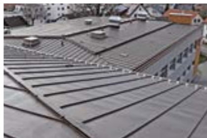
Dachdeckung mit Kupferblech
