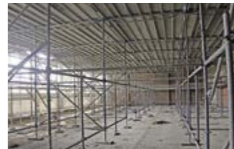
Raumgerüst in der Turnhalle
