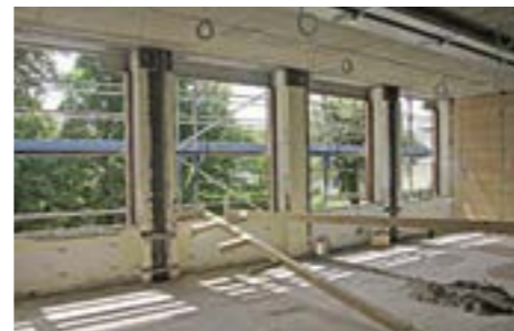
Klassenzimmer im Erdgeschoss
